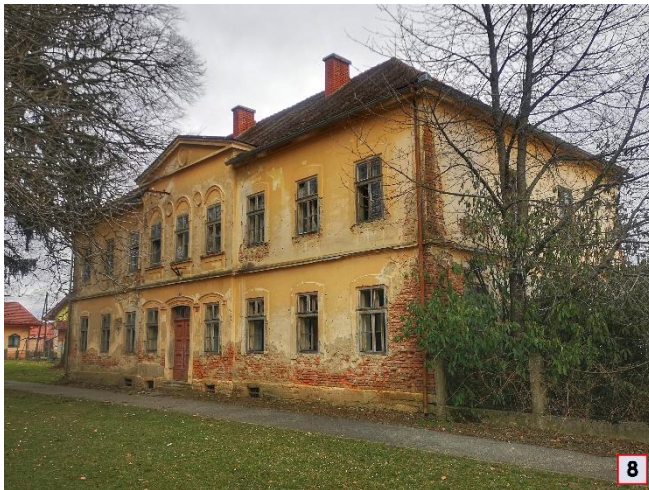
Puconci, zgradba nekdanje evangeličanske šole
